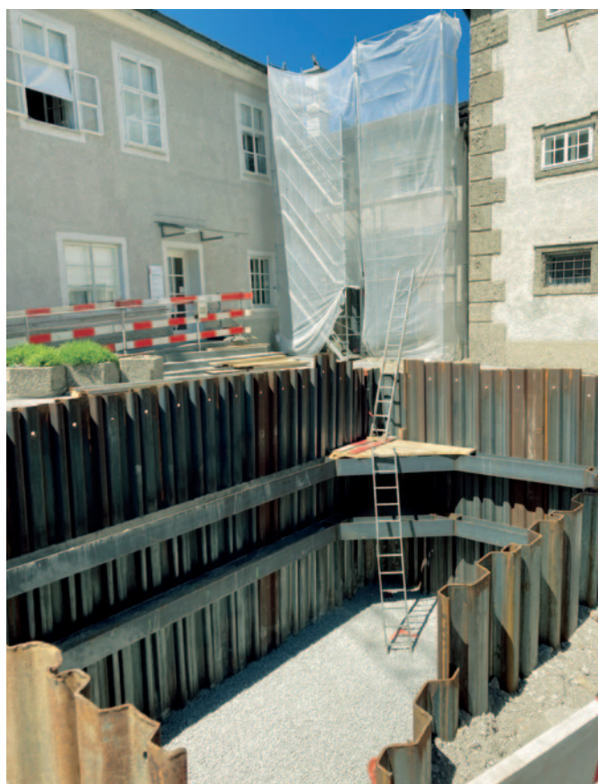
🚧 Baugrube für den neuen Trafo
