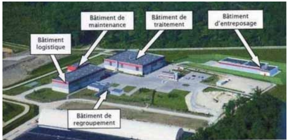
Das Zentrum für sehr schwach radioaktive Abfälle in einem Wald bei Morvilliers, Süd-Champagne. Im Uhrzeigersinn: Logistikgebäude, Wartungsgebäude, Konditionierungsanlage, Zwischenlager und im Vordergrund die Sortieranlage.
